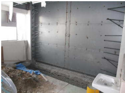
1階の女子更衣室とエレベーターの間に厚い補強が入りました。
