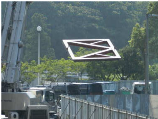
ブレースと呼ばれる補強材がクレーンで吊り上げられています。
