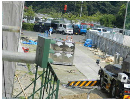
屋上にある貯水タンクが新しくなりました。(今からクレーンで吊り上げるところです。)
